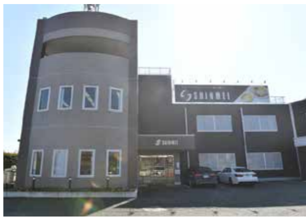
中が工場とは思えないモダンな外観の横浜本社工場。
